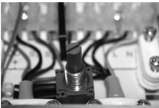
Abbildung zeigt Potentiometer in der Einstellung mit maximaler Reduzierung des Abluftstroms
