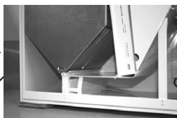
Bypassklappe in Sommerstellung.
