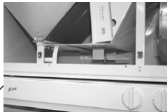
Umschaltklappe in Winterstellung
