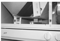
Umschaltklappe in Sommerstellung. Die Umschaltklappe kann durch Verschieben derselben hinter die Halterung in Winterstellung gebracht werden.
