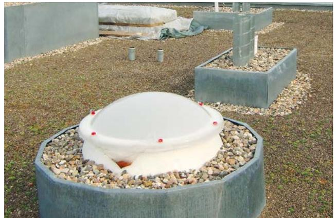
Die Außenluft- und Fortluftleitungen verlaufen für alle Wohnungen in Installationsschächten und münden über das Flachdach.
