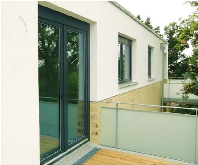
In der Außenfassade konnten Wandschneidungen und Lüftungsgitter durch die Führung von Außenluft und Fortluft über Dach vermieden werden.
