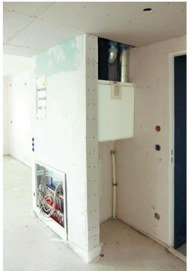
Kontrollierte Wohnungslüftung ist auch im Geschosswohnungsbau längst kein Nischenprodukt mehr. In einem viergeschossigen Neubauobjekt mit 18 Wohneinheiten wurde jede Wohnung mit einem eigenen Kompaktlüftungsgerät mit Wärmerückgewinnung ausgerüstet.
