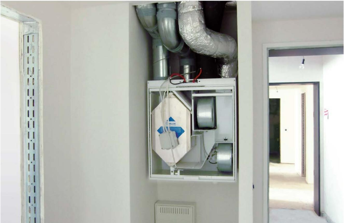
Jede der 18 Wohnungen ist mit einem VALLOX-Kompaktlüftungsgerät ausgerüstet. Der integrierte Kreuz-Gegenstrom-Wärmetauscher erzielt einen Wärmerückgewinnungsgrad von bis zu 90 Prozent.
