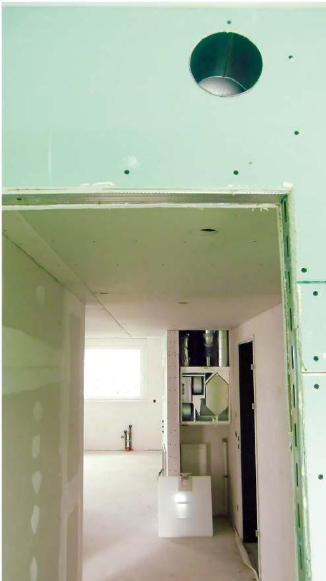
Die Luftverteilung für Zuluft und Abluft innerhalb der Wohnungen verläuft in einer Deckenabhängung im Flur mit 15 cm lichter Höhe. Dadurch waren mit den verwendeten ValloFlex Lüftungsrohren (Durchmesser 75 mm) auch Leitungskreuzungen kein Problem.
