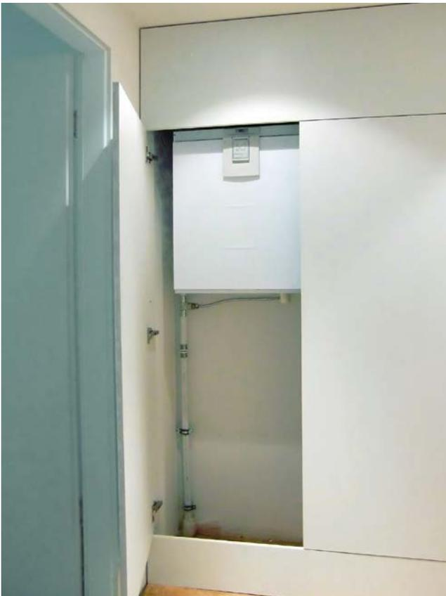
Die Kontrollierte Wohnungslüftung findet durch die kompakten Abmessungen ihren Platz in Abstellräumen oder Wandnischen. Die Kondensatableitung wurde mit einer Sammel-Entwässerungsleitung (im Bild links neben dem Lüftungsgerät) gelöst.
