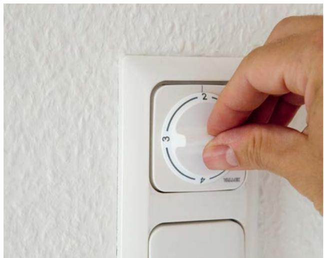
Mittels 4 Stufen-Schalter kann die Luftleistung/ Frischluftzufuhr vom Wohnungsnutzer bedarfsgerecht gesteuert werden.
