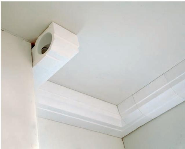
Mit den vorgefertigten, nur noch einzusteckenden Innen- oder Außenwinkeln so lange fortfahren, bis um alle Flurecken herum die gesamte Wohnung „verrohrt“ ist.
