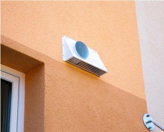
Mit der umfassenden Fassadensanierung wird als Schutz vor Schimmel auch eine Komfortlüftung installiert – hier die „Schnittstelle“ für Außen- und Fortluft.
