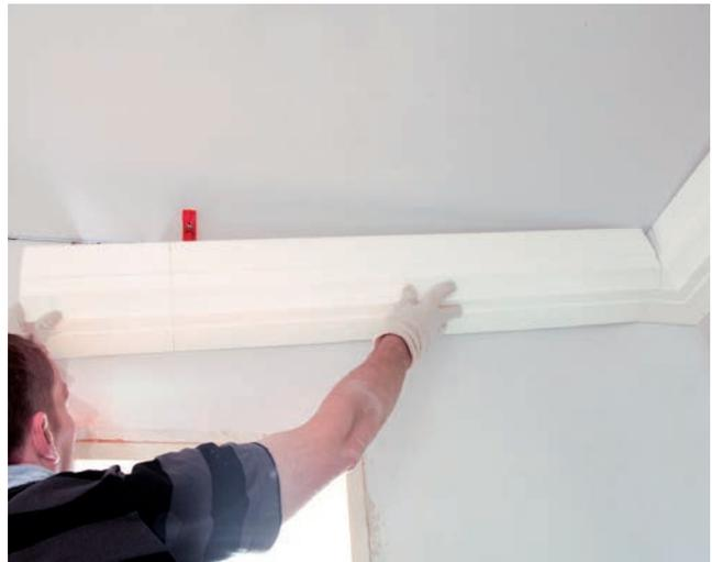
Das passend abgelängte Kanalelement mit Verbinder einklicken.
