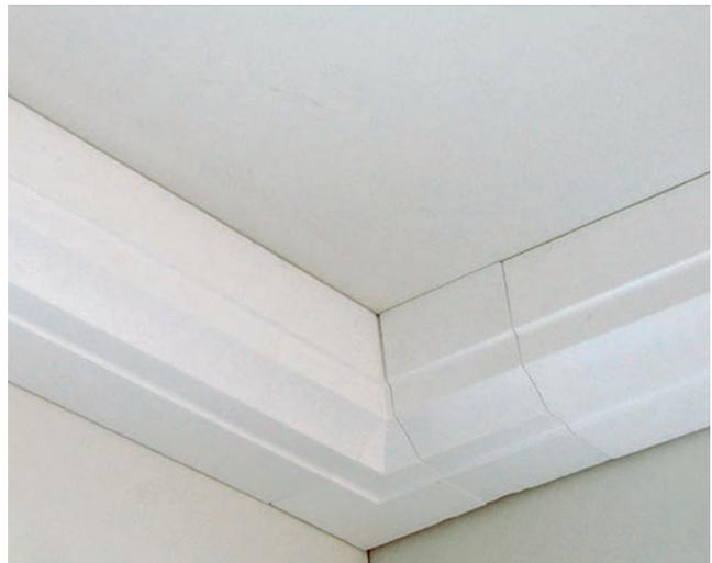
Eventuelle Fugen, die gerade bei einer Sanierung fast immer entstehen, werden später schnell und einfach mit dauerelastischer Masse abgedeckt.
