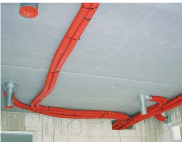
In Räumen mit Deckenabhängung wurden Ventilanschlussteile installiert, in die bei der Endmontage Tellerventile eingesetzt werden.
