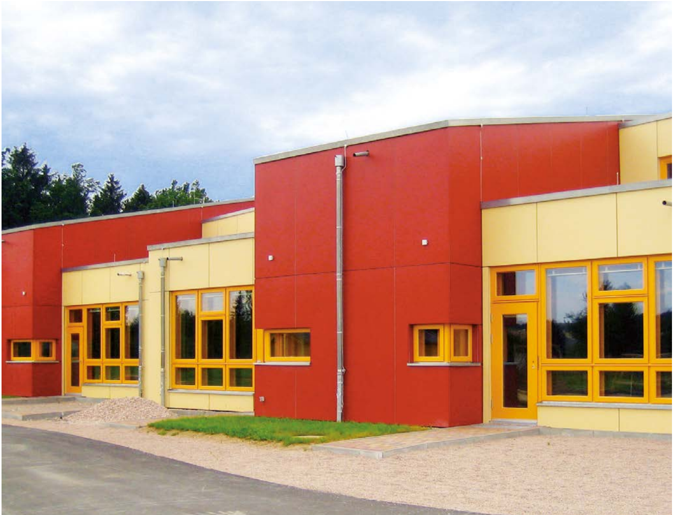
1 – Außenansicht Kindergarten in Oelsnitz/Erzgebirge
