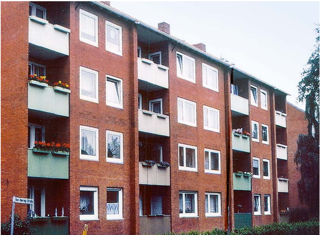
Zustand vor der Sanierung
