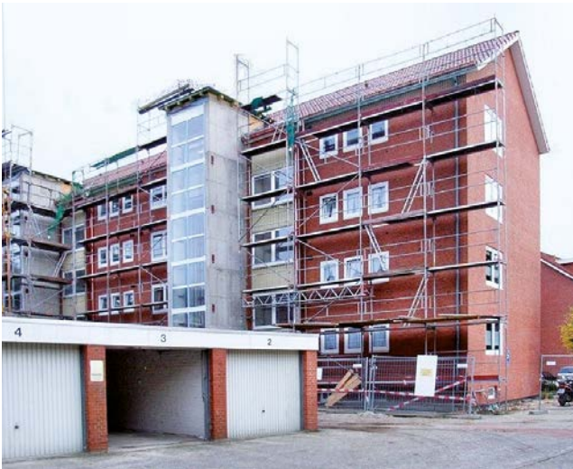
Momentaufnahme während der der Sanierung
