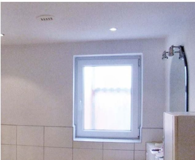
ValloFlex Abluftventil in der Baddecke
