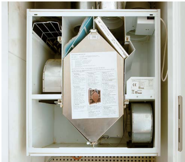
3 – Vallox-Lüftungsgerät mit Wärmerückgewinnung im Bad (ohne Gehäusedeckel)
