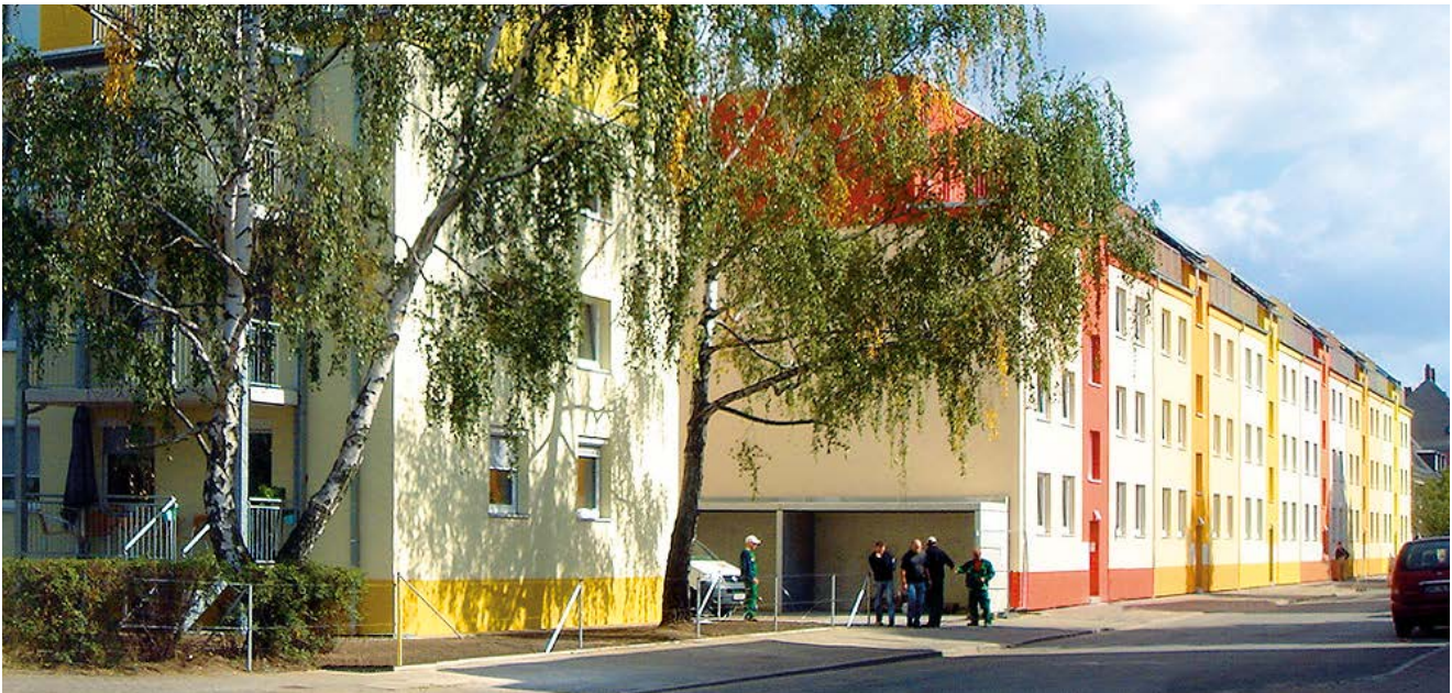
Das Altbausanierungsprojekt mit Passivhauskomponenten – Frankfurt am Main, Tevesstraße
