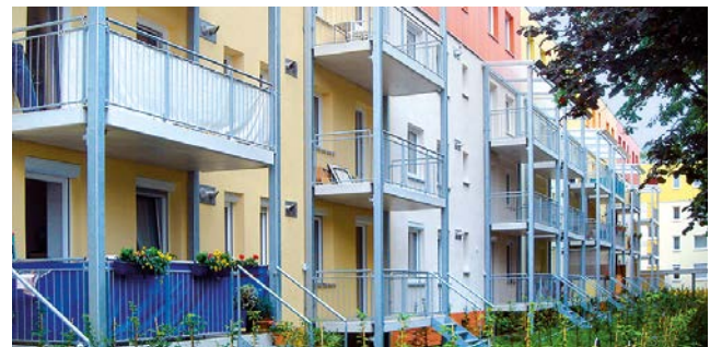
4 – Außenansicht mit Balkonen sowie Luften und -auslässen
