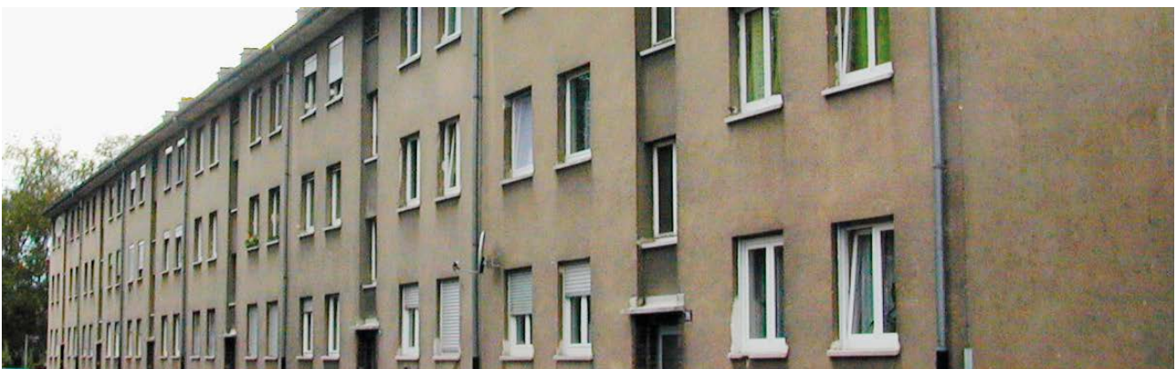
1 – Bestand vor der Sanierung
